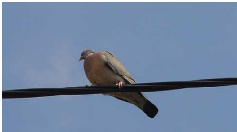
Rys.1 Linia nn z przewodami izolowanymi – bezpieczna dla ludzi i... ptaków
