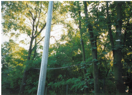
Rys.5 Linia „tymczasowa”, przewody zamocowane bezpośrednio na drzewie - jedna z obwodnic Paryża
